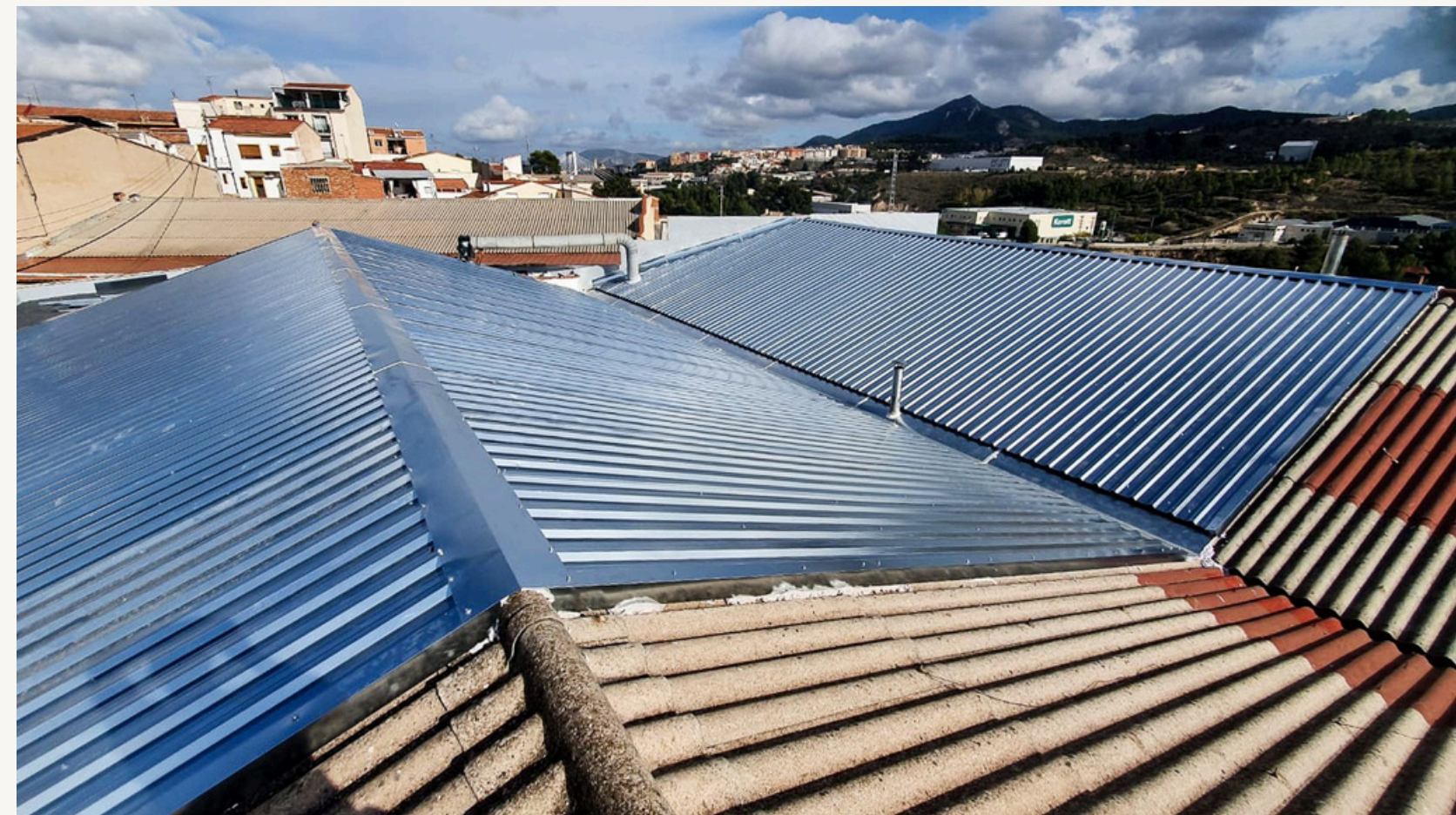
Confinat amb planxes d'acer galvanitzat
