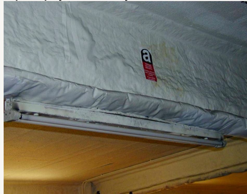
Espuma projectada sobre jàsera d'acer
