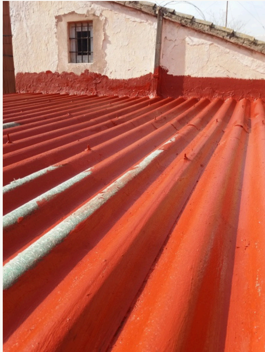
Encapsulat amb pintura de clorcautxú
