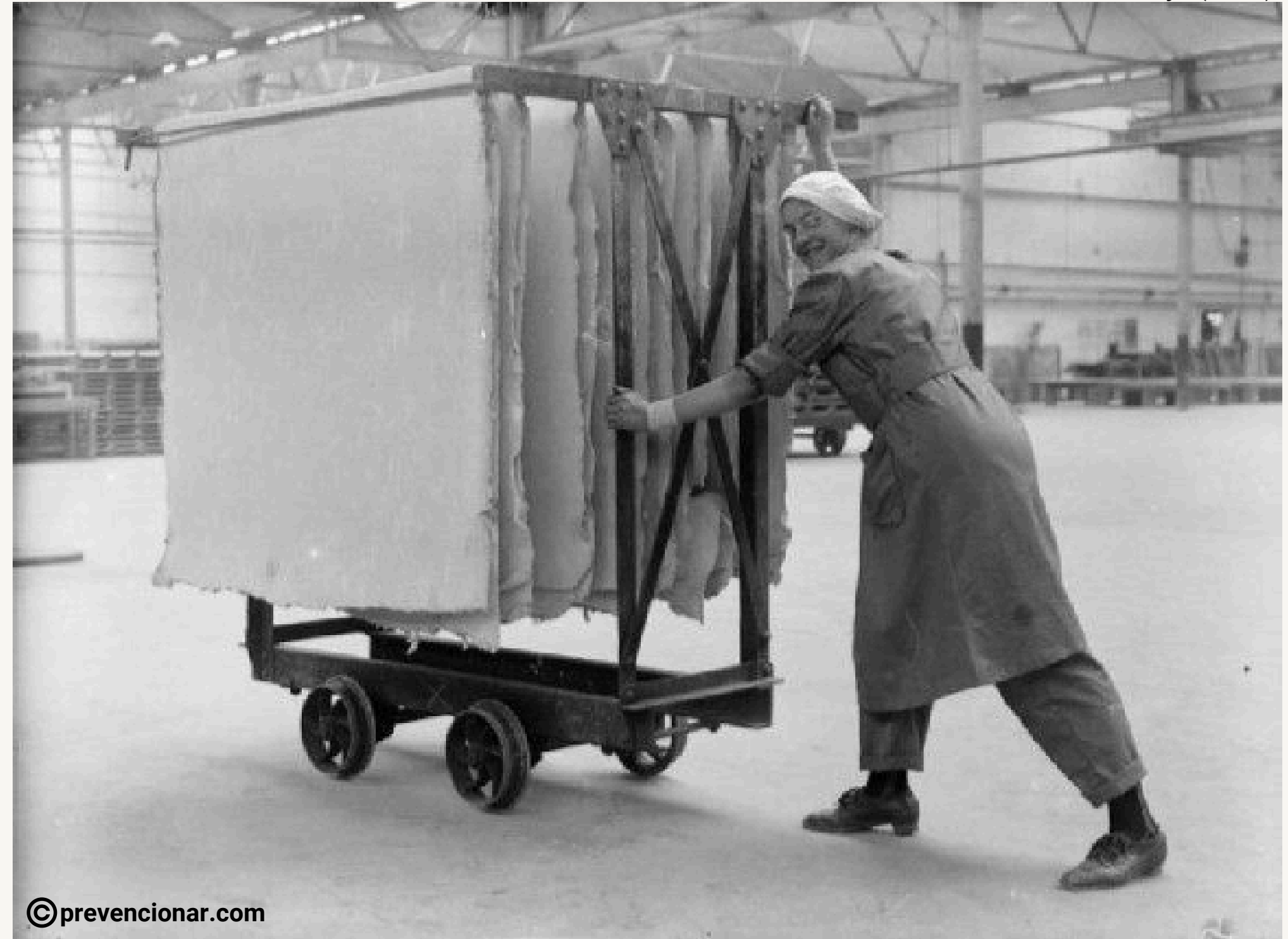
Transportant teles d'amiant
