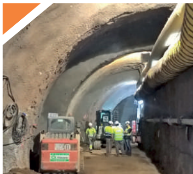
► Limpieza de galería excavada
