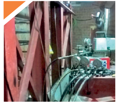
► Apeo Vigas calle Rosselló
