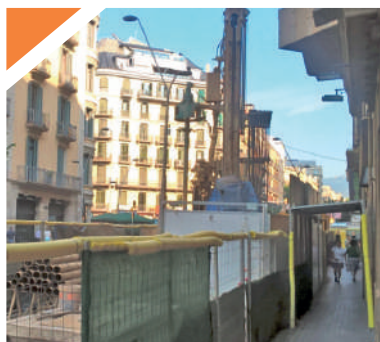
► Protecciones a terceros en trabajos de pilotaje
