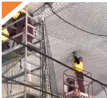
► Colocación de red protectora en bóveda estación
